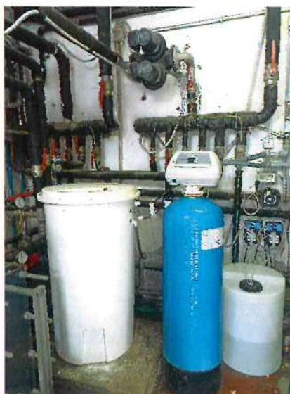
Foto 4 – Addolcitore e Impianto antilegionella con pompe dosatrici acqua calda e fredda.
