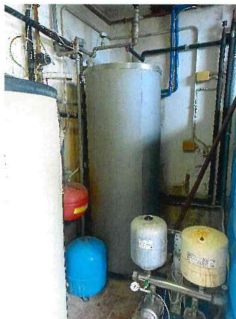
Foto 4 boiler preriscaldamento da solare termico 546 lt.
